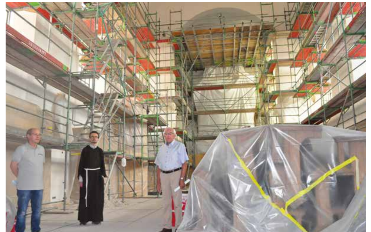
Restaurator Horst Neumann, Guardian Pater Romuald und Bauleiter Heinz Üttermeier sind mit dem Fortschritt der Renovierung zufrieden.
