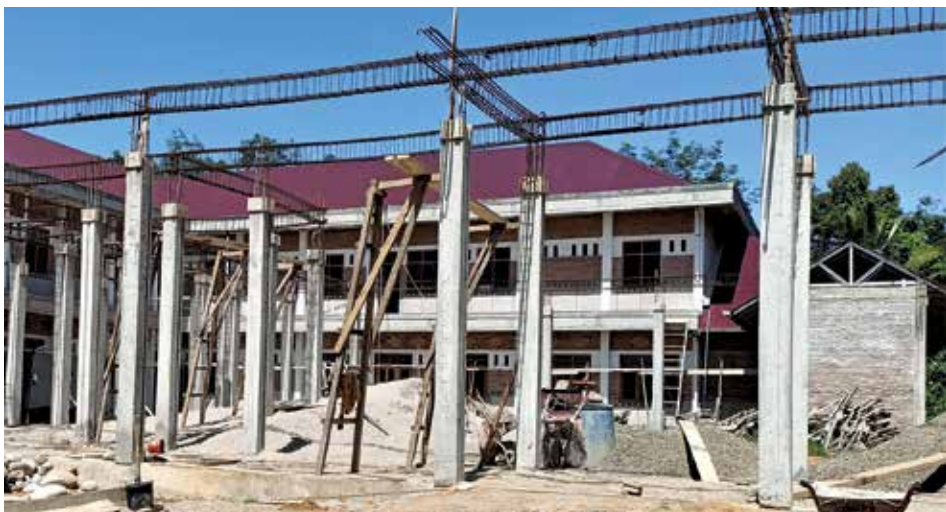
Im zweiten Bauabschnitt werden die Kapelle und der Gästebereich gebaut.
